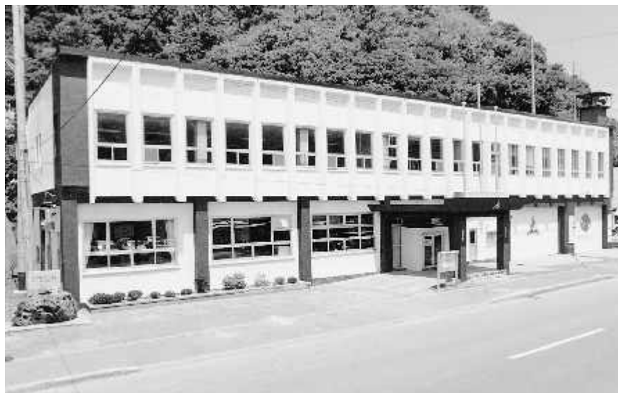
平成元年に増改築した現庁舎
