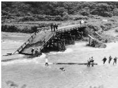
昭和36年災害 <ヤエダウス橋>
