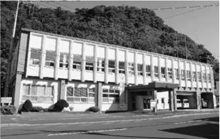
平成元年に増改築した現庁舎
